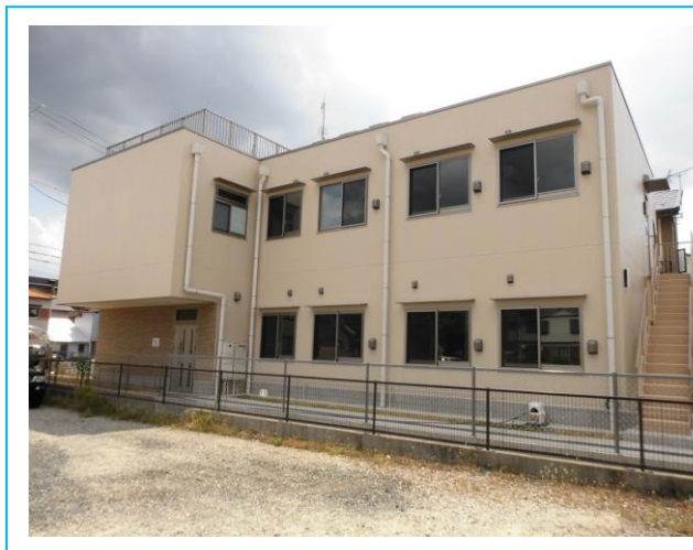
居室と非常階段(東側から)
